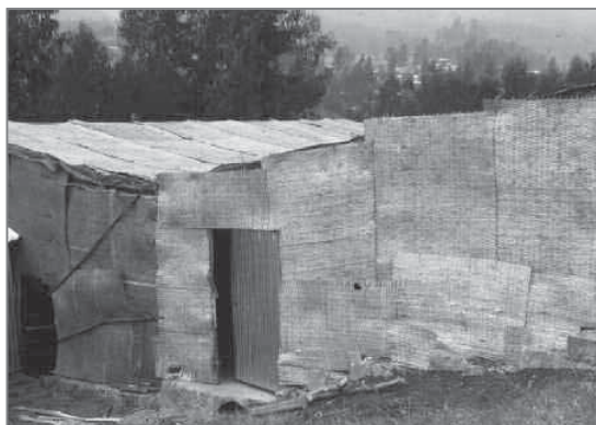
شکل ۳ | یک سالن ساده پرورش قارچ که از مواد محلی موجود از جمله چوب خیزران ساخته شده است
