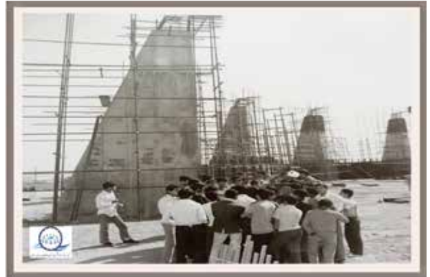
بازدید دانش آموزان از مراحل احداث منابع آب هزار جریب - اوایل دهه ۱۳۵۰
